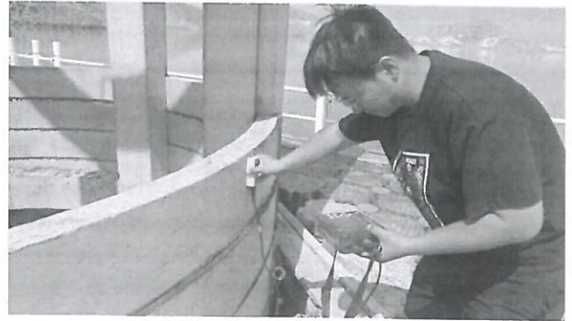
图 3.2.2-8 现场检测照片
