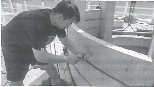
图 3.2.2-7 现场检测照片
