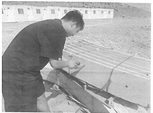
图 3.2.2-6 现场检测照片
