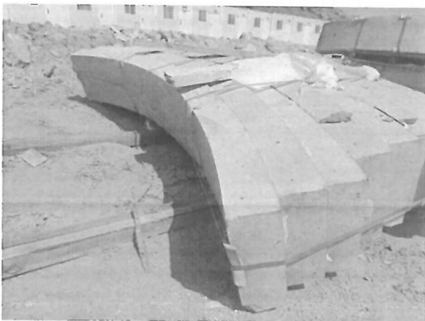
图 3.2.2-5 排水井拱盖板现状照片
