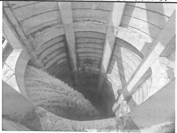
图 3.2.2-2 排水井内景现状照片
