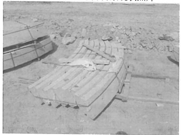
图 3.2.2-4 排水井拱盖板现状照片
